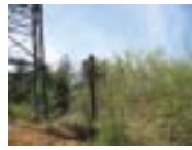
送電鉄塔付近からの眺め
